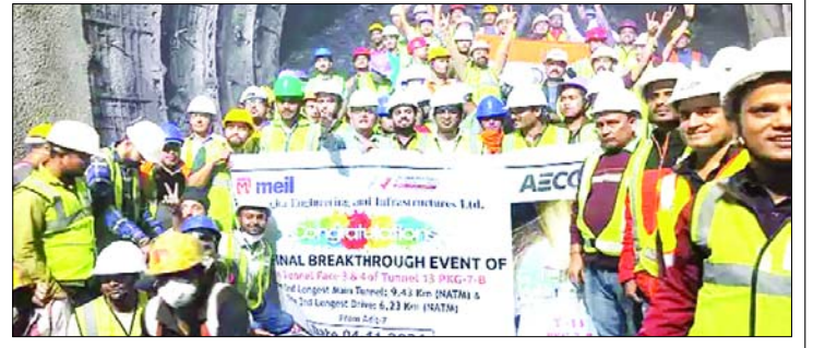
परियोजना प्रबंधक एचएन सिंह ने बताया कि रेल लाइन परियोजना की यह तीसरी बड़ी सुरंग है। इसके निर्माण में कई दिक्कतें भी आईं, लेकिन उनका सफलतापूर्वक सामना किया गया।
